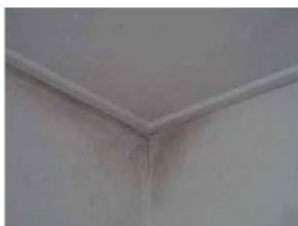
Indvendig termografering. M1: Utæthed ved samling mellem loft og skillevæg
