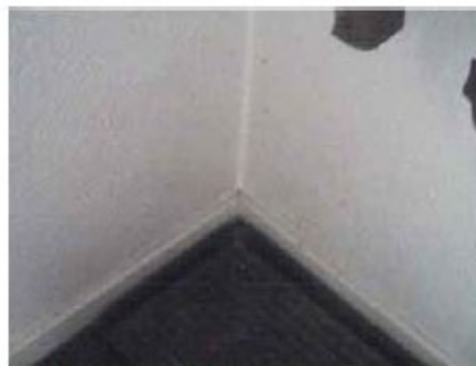
Indvendig termografering. M1: Utæthed ved bundstykke/fodliste
